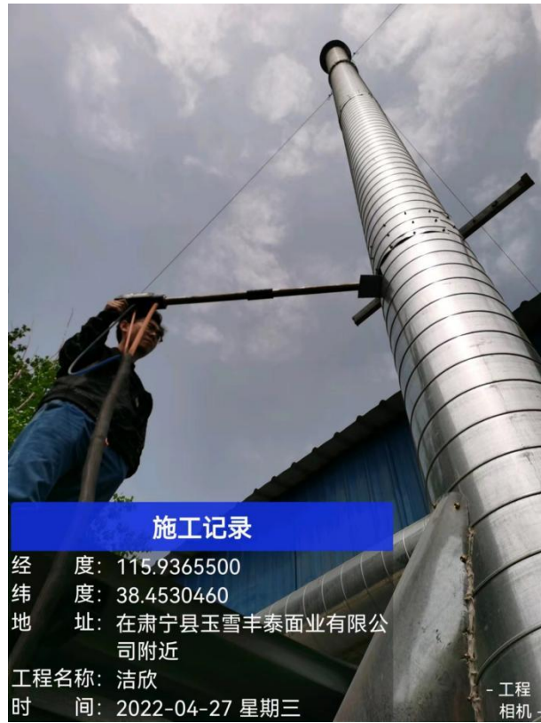
图 3-1 废气治理设施现场图
