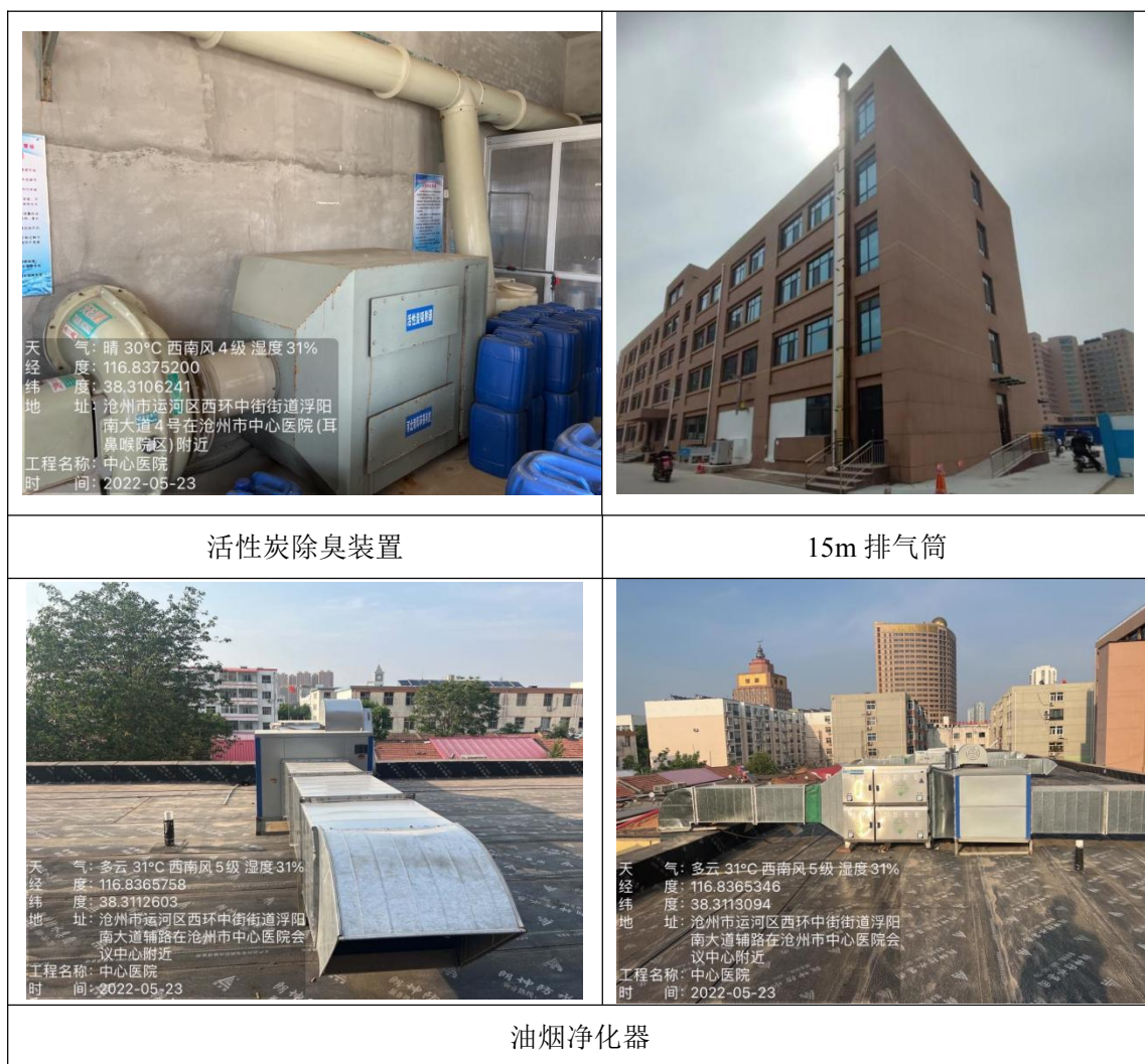
图 4-2 废气治理措施
