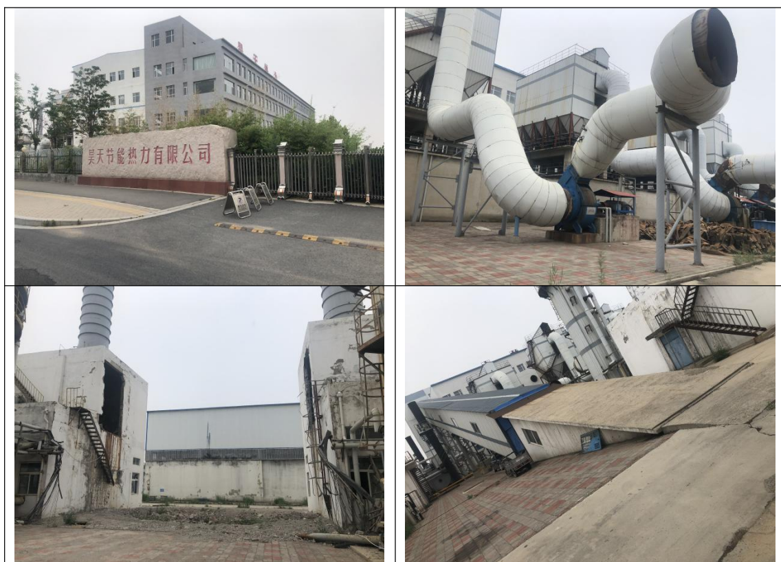
图3.3-1 沧州昊天节能热力有限公司2021年场地调查时照片
