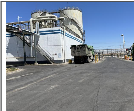
1A污水处理站
