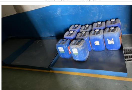
1F飞灰暂存间、危废间
