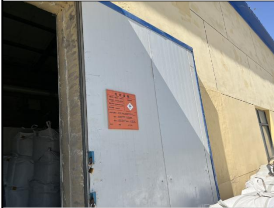
1F飞灰暂存间、危废间
