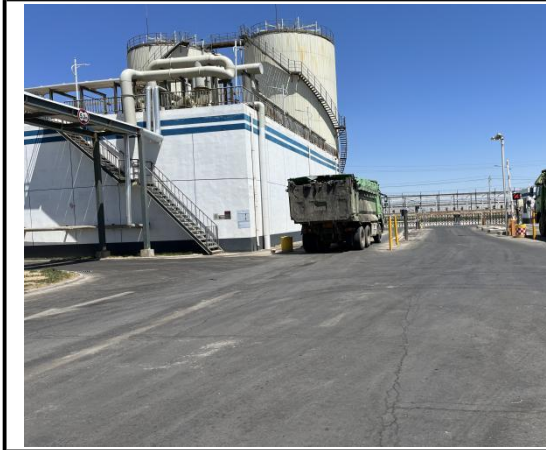
1A污水处理站
