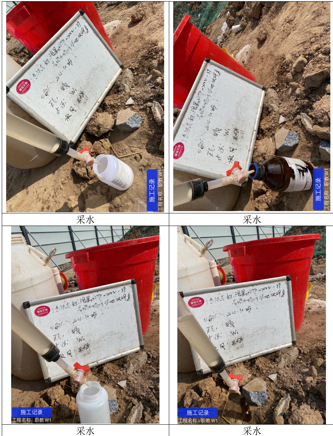
图4.2-2 地下水建井洗井、采样照片
