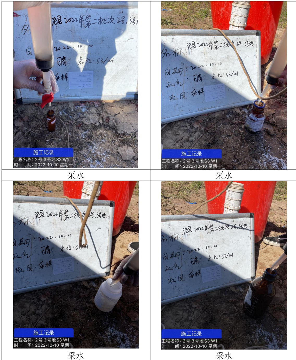
图4.2-2 地下水建井洗井、采样照片
