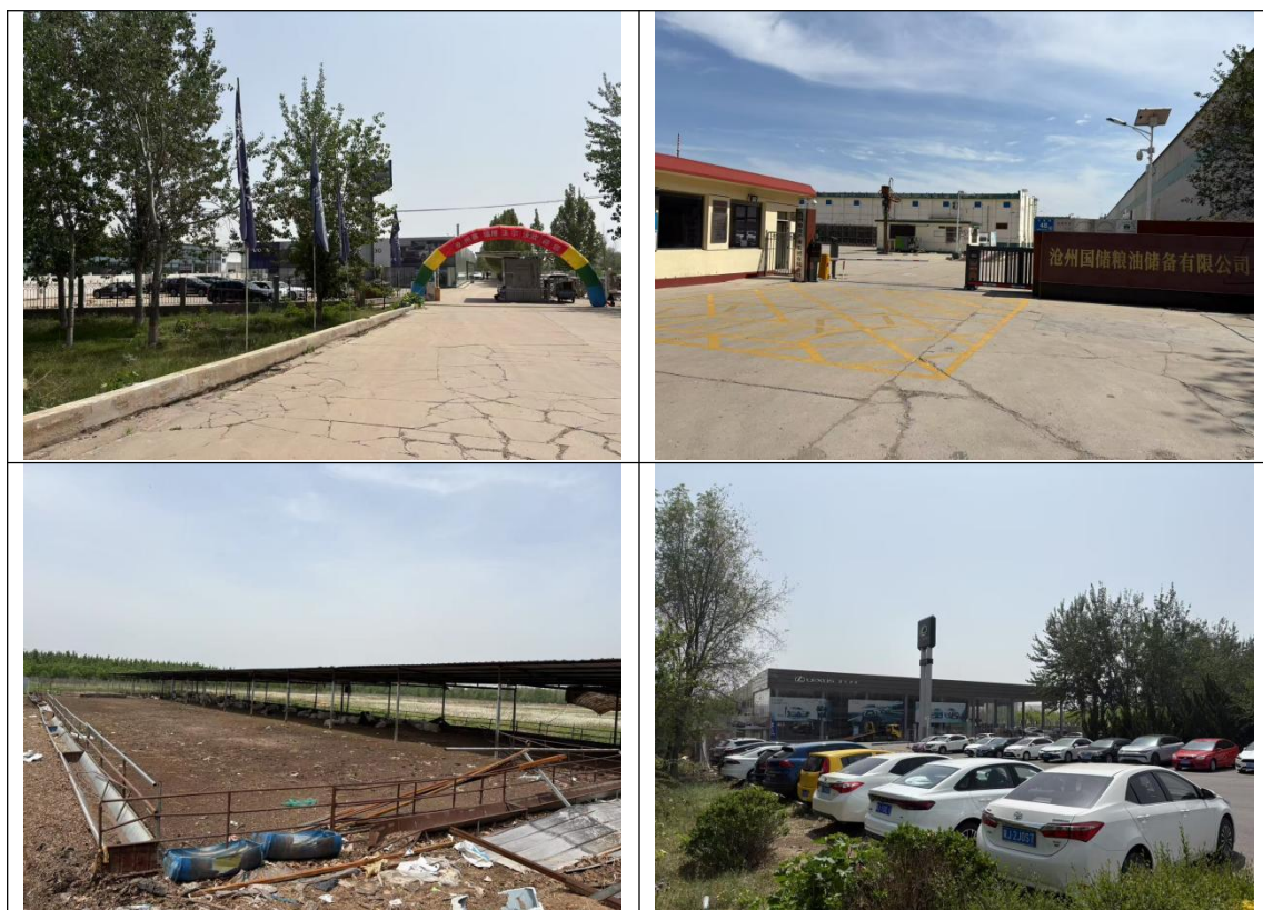
图 3-12 周边 1km 范围部分企业现状照片
