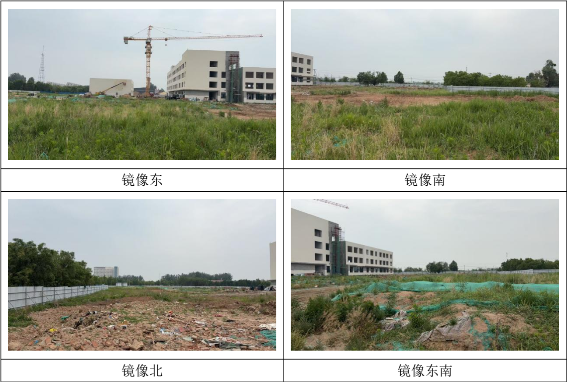
图 3-9 地块现状照片
